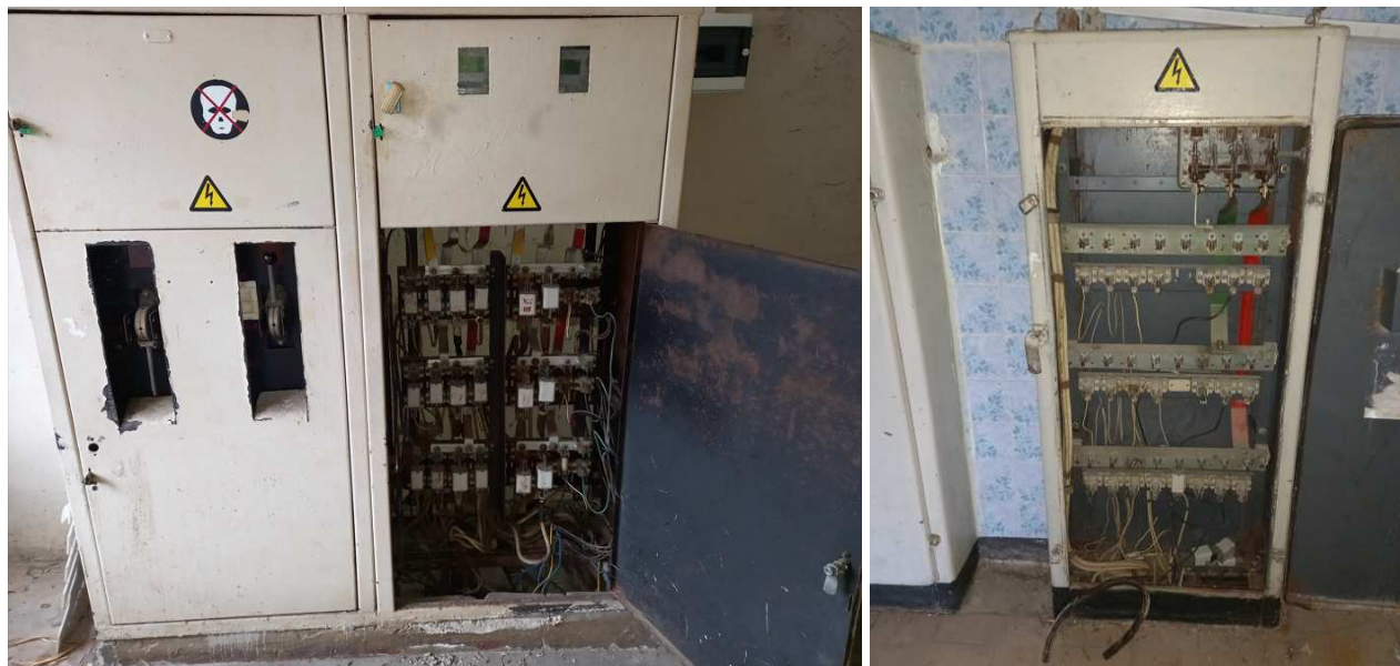
2 pav. Kapitališkai rementuojamo specialiosios paskirties pastato įvadinis ir paskirstymo skydas
